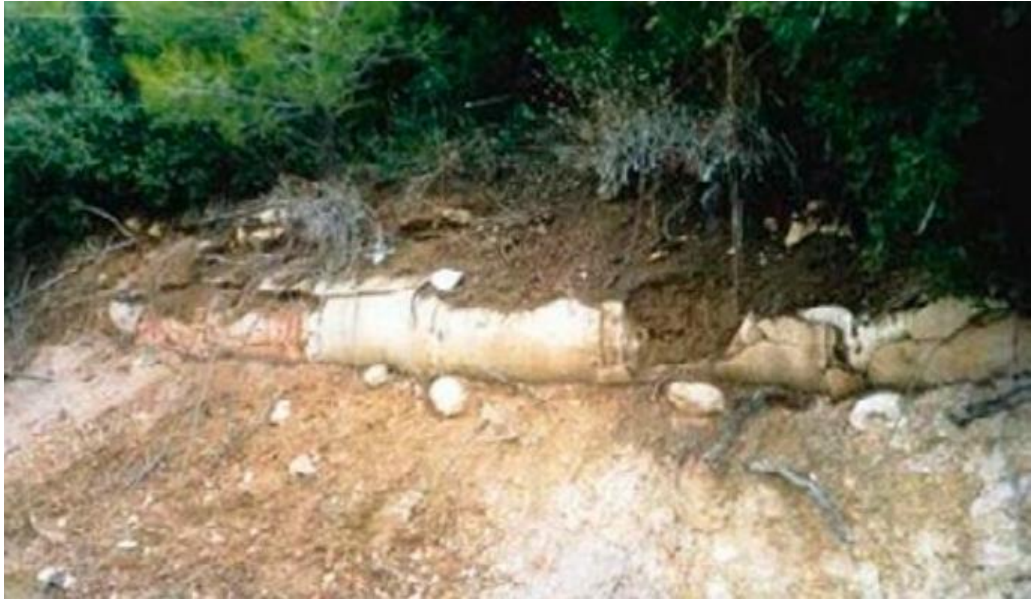
Şekil 3.2: Hierapolis-Çaltılı hattı pişmiş toprak boru. [6].
